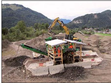
Mittlerweile sind 60 % des Volumens ausgebaggert, gesiebt und sämtliche Teile über Handtellergröße händisch sortiert – in Autoreifen, Holz, Glas, Eisen und Nichteisenschrott (insgesamt 10 Sorten), Restmüll (hauptsächlich Plastik) und gefährlichen Abfall (überwiegend Altöl und Batterien).
