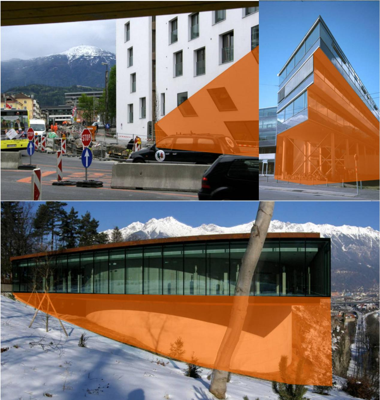
Abbildung 8: Beispiele anhand gebauter Objekte. Die orange markierten Bereiche gehören auch zur Baumasse
